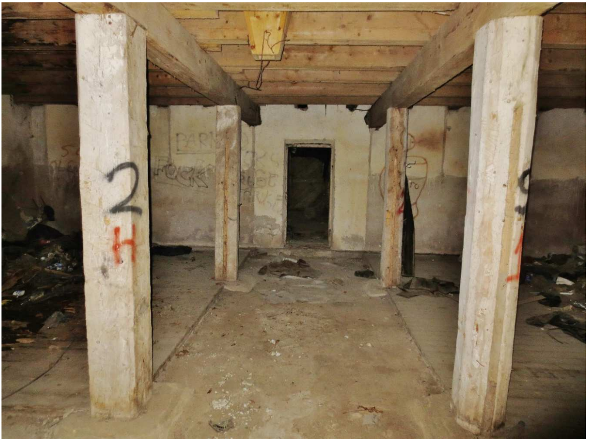
25. Vaade I korrusele loode suunas. Ukseava U5.
