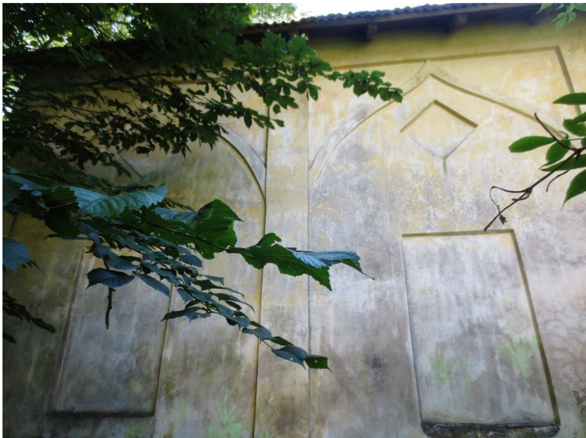
2. Vaade ajaloolisele krohvdekooriga kirdeseinale
