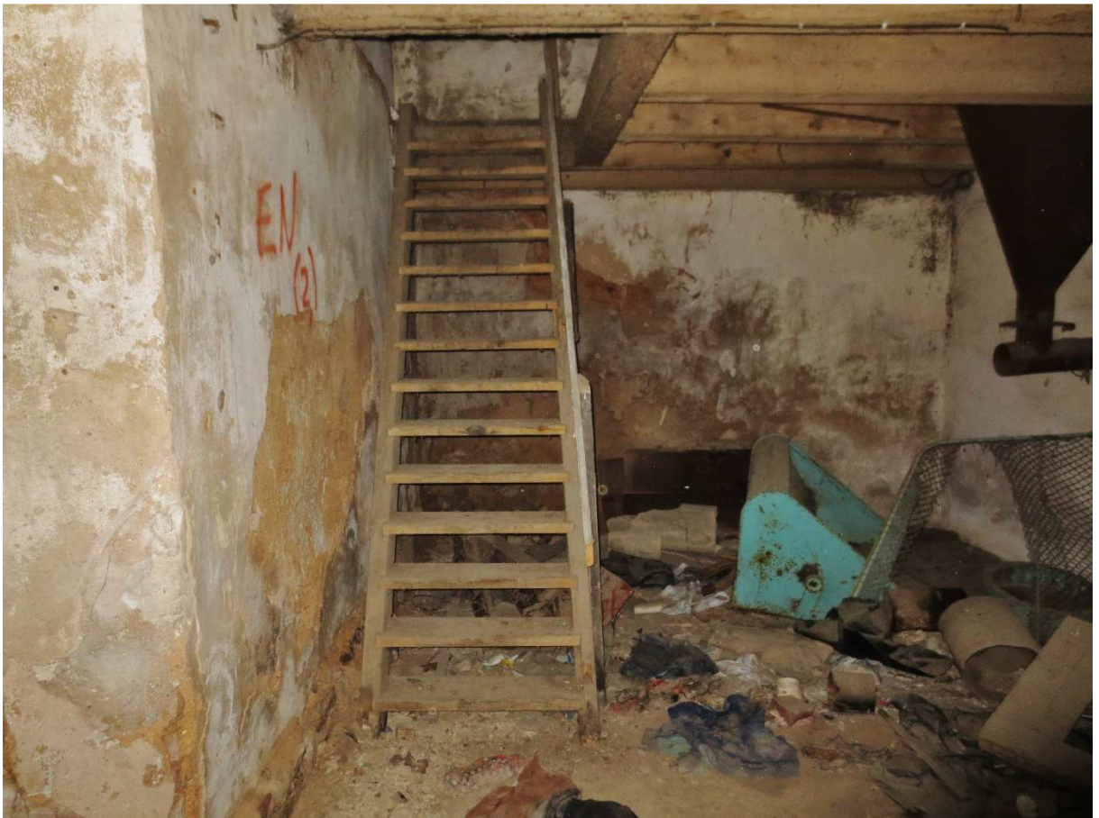
19. Trepp ajaloolise hooneosa I korruse eesruumi
