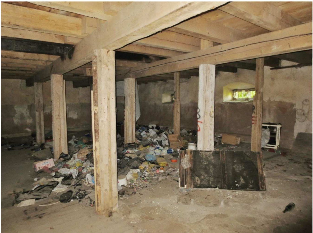
24. Vaade I korrusele lõuna suunas
