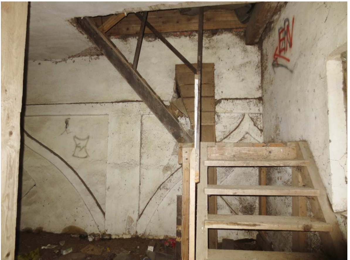
32. Ajaloolise hooneosa kirdeseina krohvidekoor juurdehituse II korrusel
