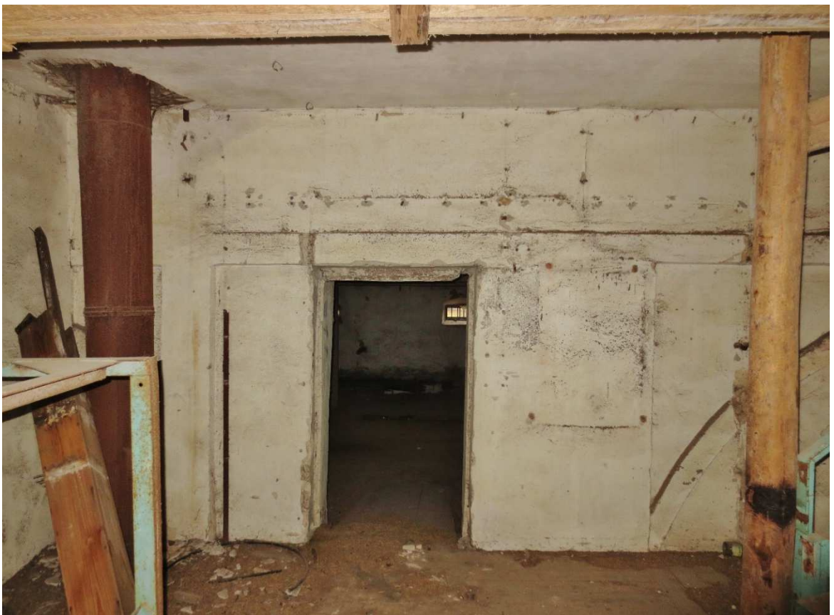
34. Juurdeehituse II korruselt ajaloolisse hooneosasse viiv ukseava U6, mis on sisse murtud juurdeehituse käigus nõukogude perioodil
