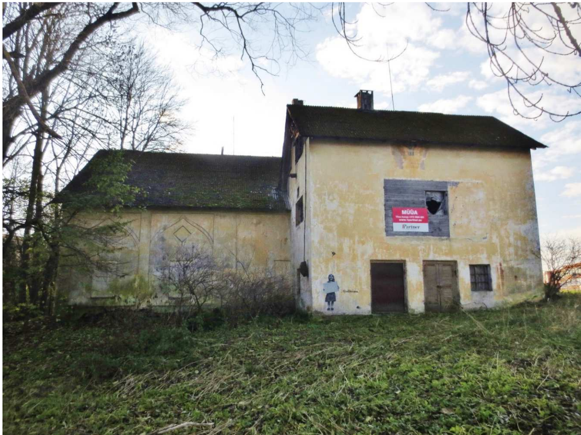
1. Vaade kirdest. Paremäl nõukogude aegne juurdeehitus
