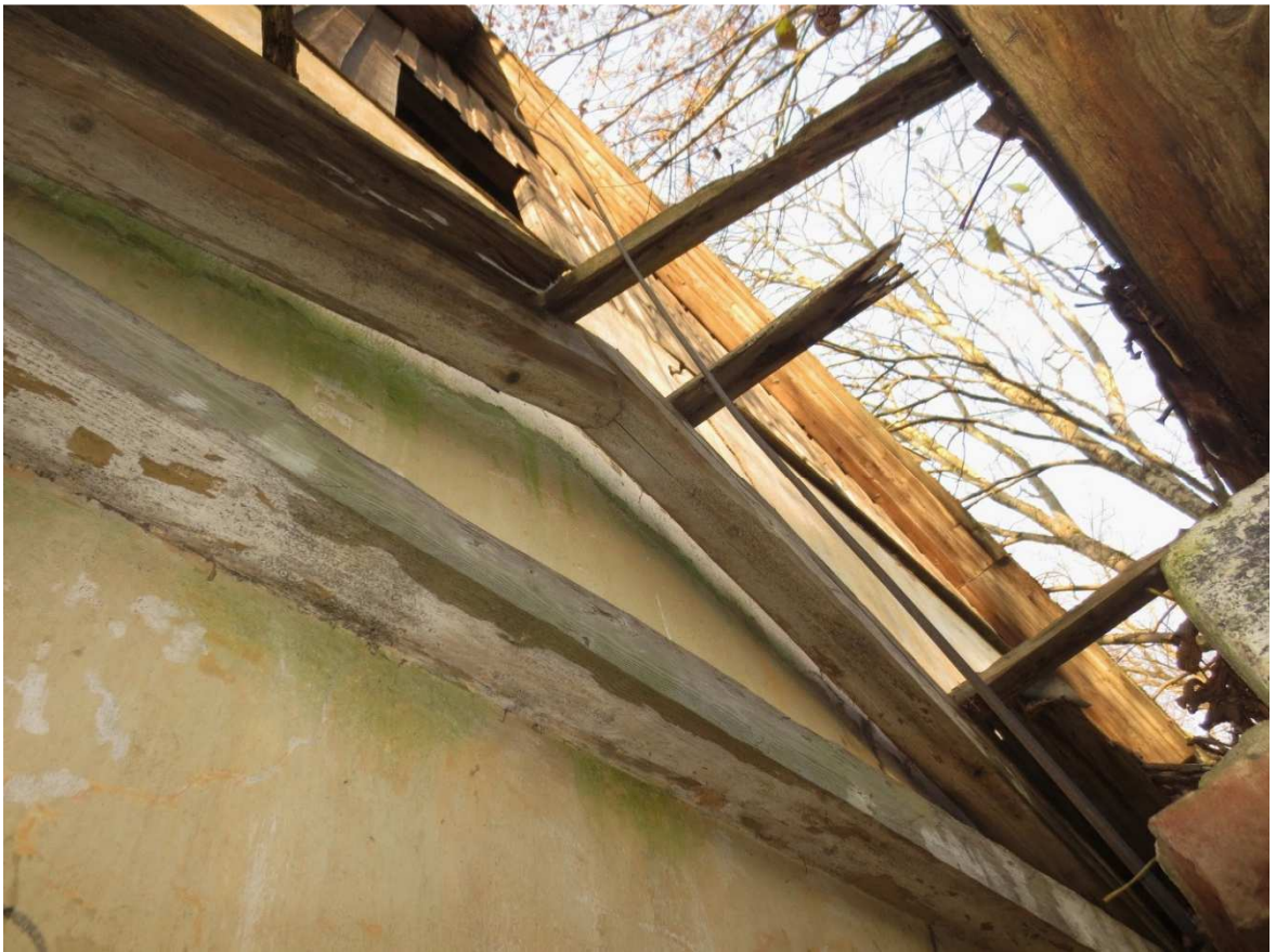
15. Sammasportikuse kolmnurkfrontooni lagunened konstruktsioon
