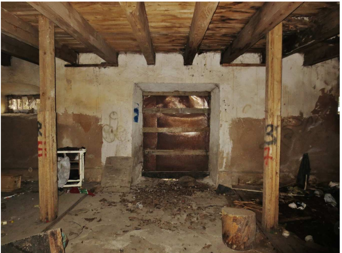
26. Vaade I korrusele edela suunas. Plekiga kaetud ukseava U1.
