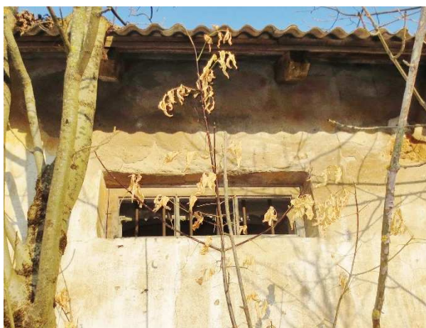
9. Vaade tagaküljele, mille ukse allserv ja sokkel on pinnasesse uppunud. Puud sokli servas
