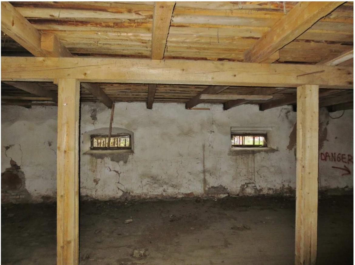
41. Vaade II korruse edelaseinale. Ühel aknal ei ole kaarsillust.
