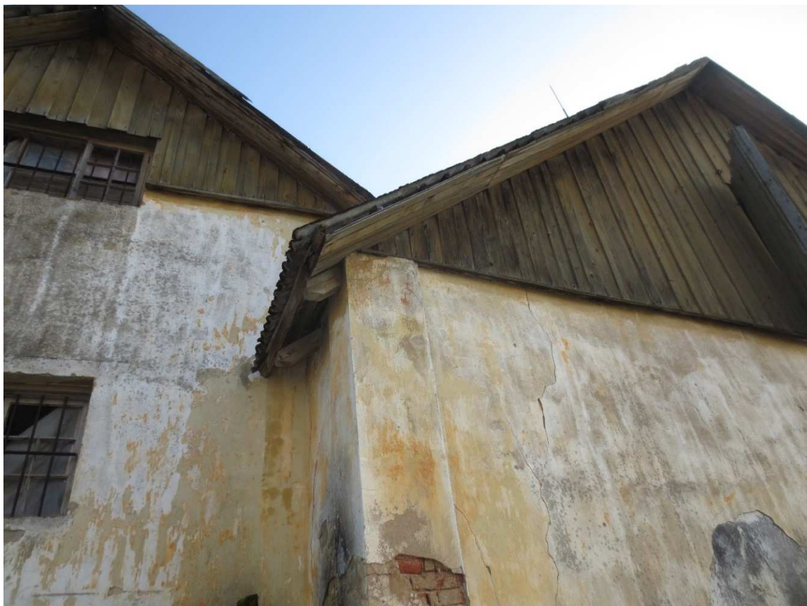
4. Mõisaaegse hoonekehandi ja hilisema juurdeehituse ühenduskoht.
