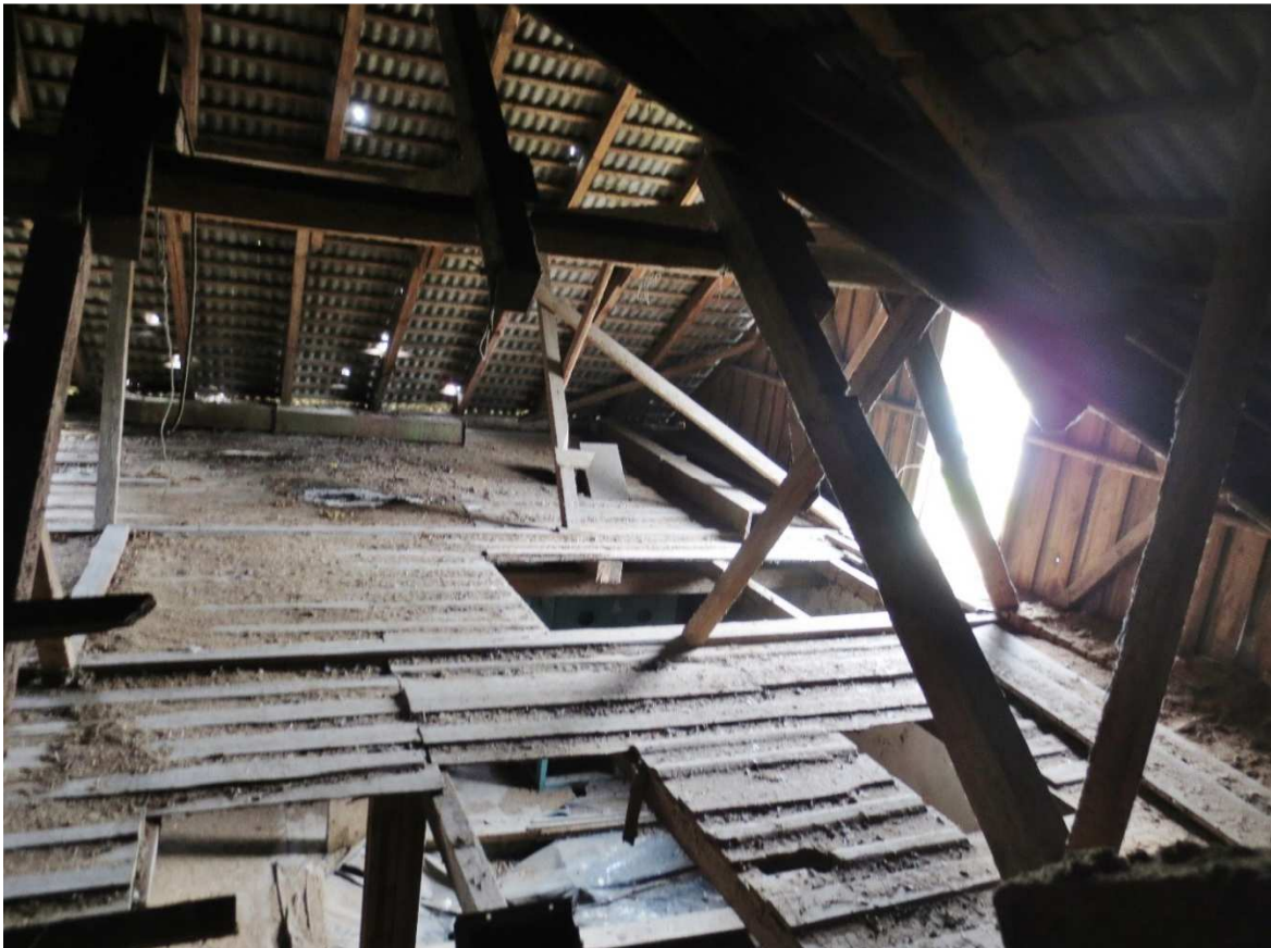
48. Vaade pööningule lääne suunas
